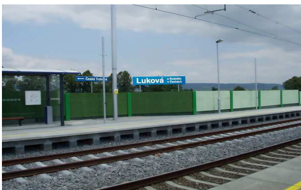
Protihluková stěna PHS 2 z recyklované pryže
