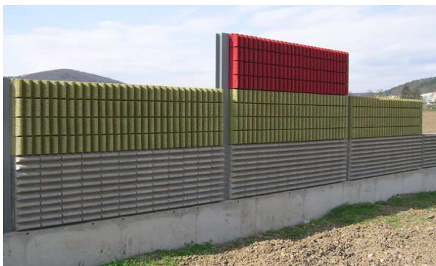
Protihluková stěna PHS 2 z recyklované pryže
