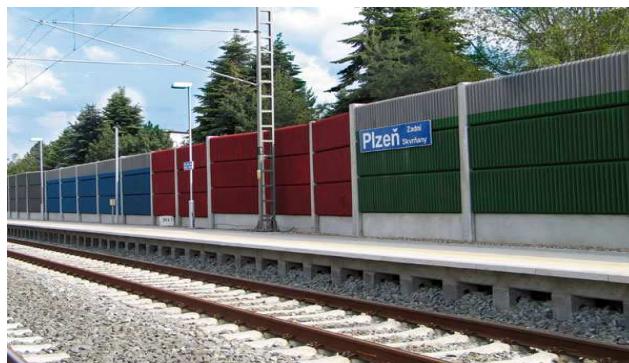
Protihluková stěna Silent – pohltivá vrstva je tvořena z mezerovitého drobnozrnného betonu (křemičité písky)
