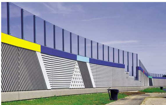
Protihluková stěna Liadur – pohltivá vrstva je tvořena lehkým mezerovitým betonem z pórovitého kameniva Liapor
